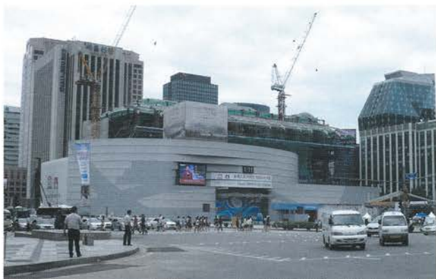
写真1 新庁舎建設中のソウル市庁（8月現在）；手前の白い部分は建築工事用防護壁で、市庁機能は近隣の分庁舎へ移転
