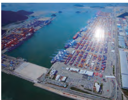
写真1. 釜山港の巨大コンテナターミナル
