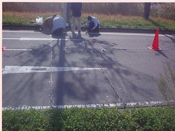
仙台空港構内の交通量計測機器設置作業
