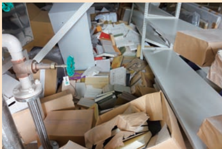
倒潰したペントハウスの内部
