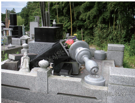
図 1. 栗原市一迫町清水普門寺の墓石転倒の様子。転倒した棹石と小さい灯籠には転倒防止施工がなされていた。
